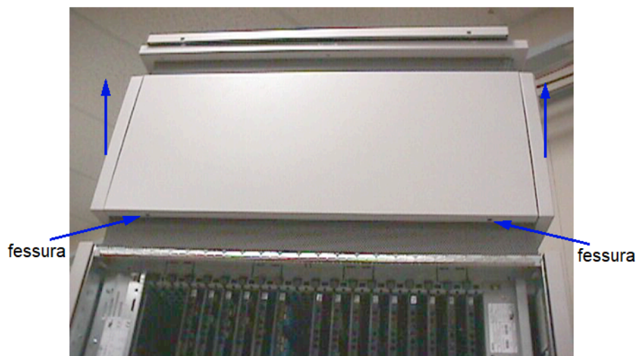
Figure 12: Rimozione delle coperture frontali 1
