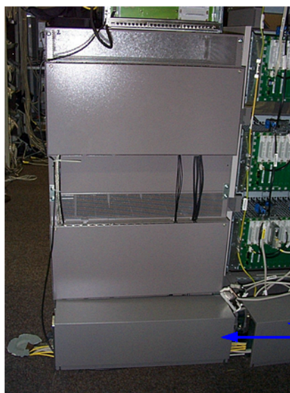
Figure 217: Apporre le coperture della canalina cavi
