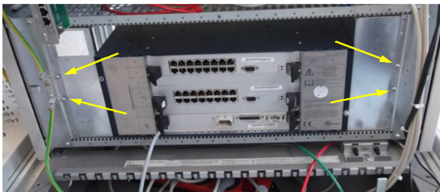
Figure 33: Rimozione del fissaggio CSPCI
