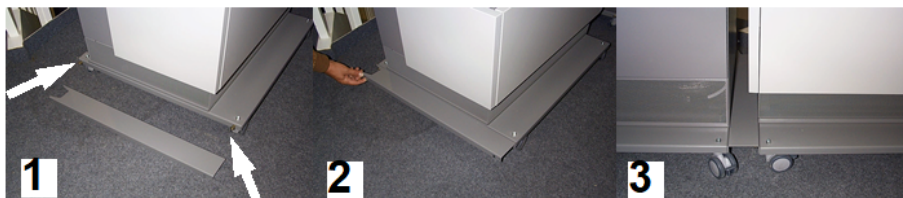
Figure 90: Fissare i coprigiunti di messa a terra alle basi dei cabinet
