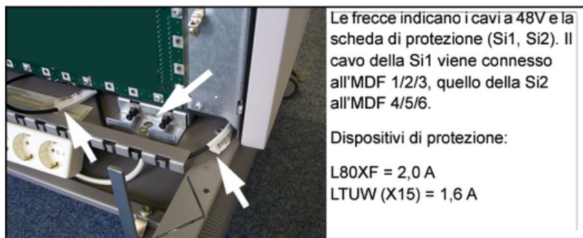
Figure 129: Scheda di protezione a -48 V per MDF (non ridondante)
