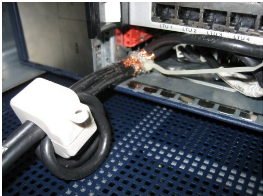
Figure 55: Nucleo in ferrite chiuso con cavi DC
