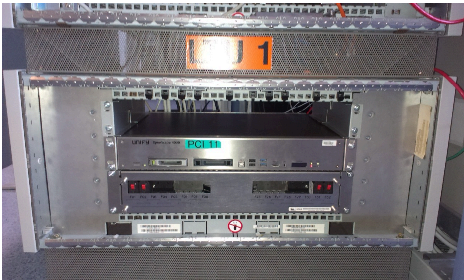
Figure 45: Connessione CC di EcoServer con DCDR (kit CC per armadio da 30")
