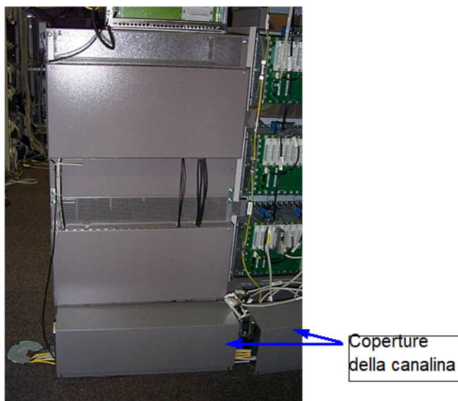
Figure 217: Apporre le coperture della canalina cavi
