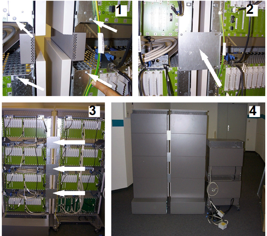
Figure 91: Montare i coprigiunti di terra tra i singoli cabinet
