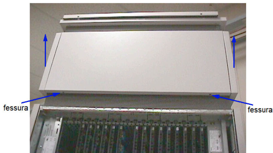
Figure 12: Rimozione delle coperture frontali 1
