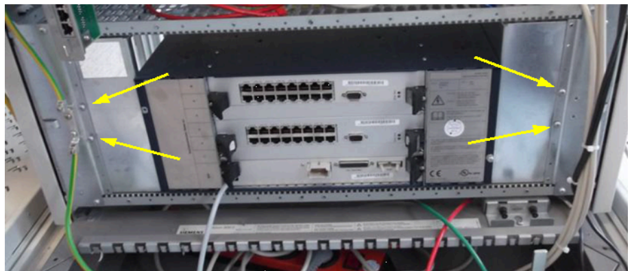
Figure 33: Rimozione del fissaggio CSPCI
