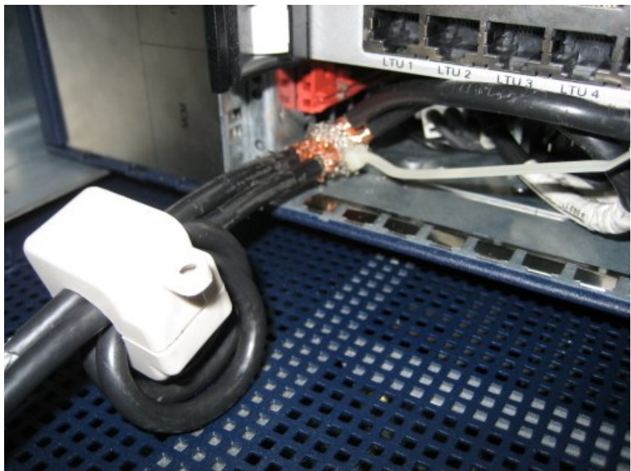
Figure 55: Nucleo in ferrite chiuso con cavi DC
